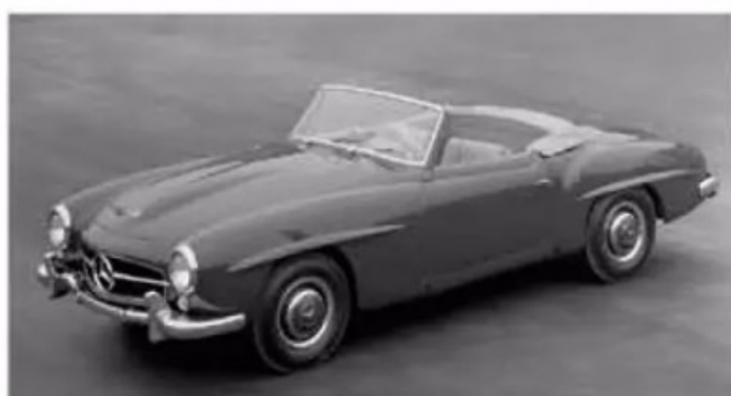
Les premiers modèles 1955 du roadster ne possédaient pas de chromes extérieurs, hormis les pare-chocs, ni de caches des trous de levage.
